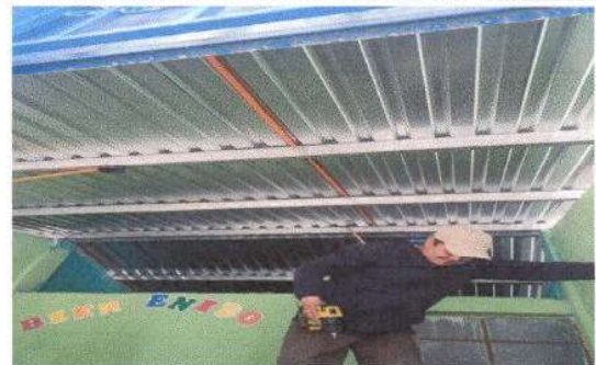
Foto 6: Reparacion de Sistema Electrico
