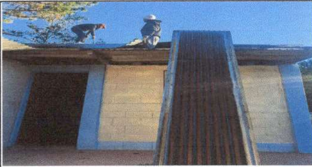
Foto1: Sustitucion de lamina troquelada aluzinc calibre 26
